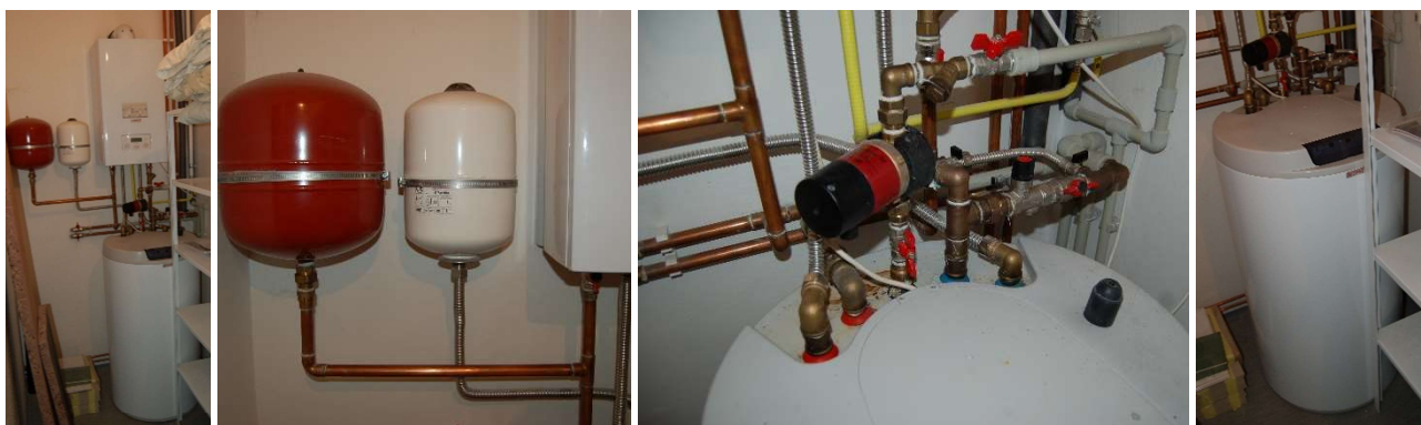
Obr. 12: Zdroj tepla – plynový spotrebič typu C
