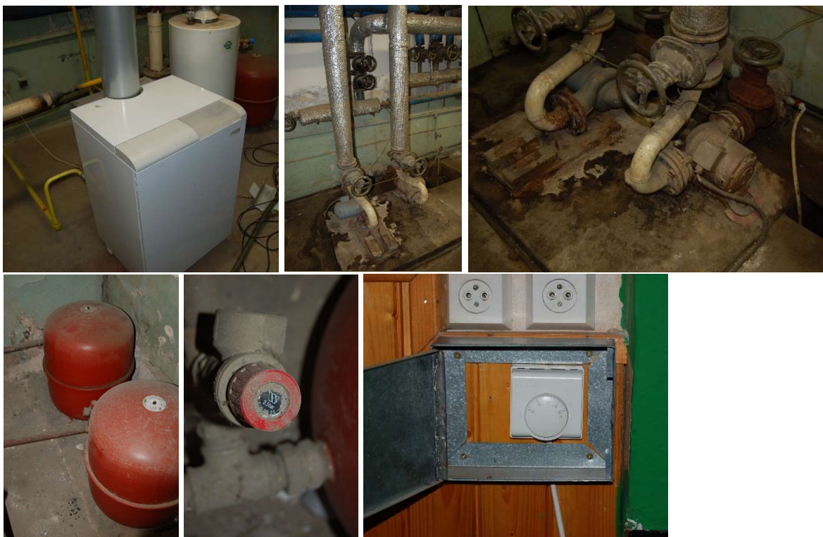
Obr. 11: Zdroj tepla - plynová kotolňa na 1 PP
