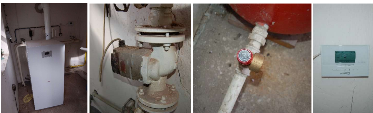
Obr. 13: Zdroj tepla – plynový spotrebič typu C
