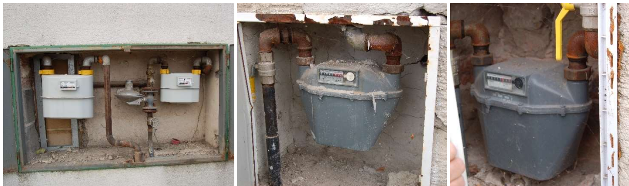
Obr. 7: Meranie spotreby ZP pre budovu KD (vľavo ČOM2, vpravo ČOM3)
